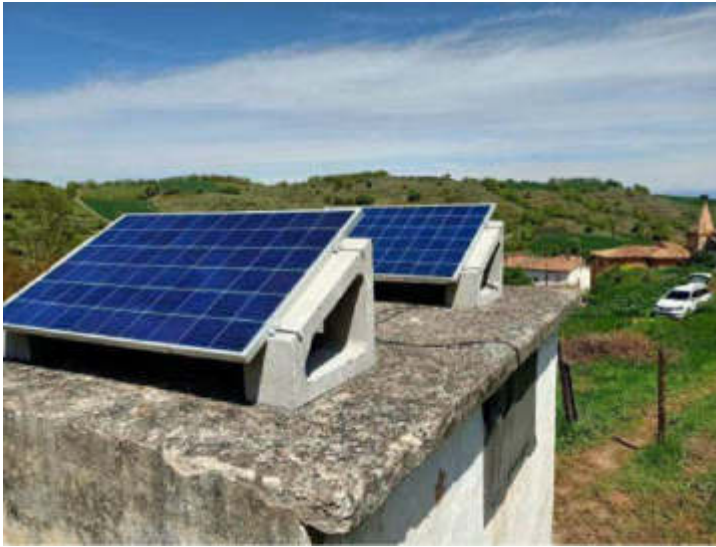
Colocación de placas solares en cubierta Detalle de soportes y anclajes de placas en cubierta
